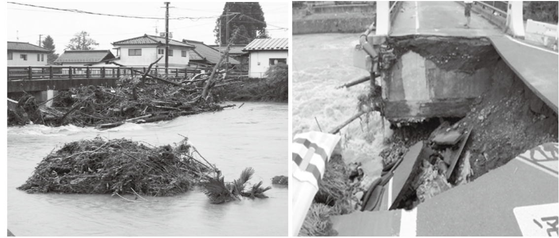
▲昨年9月の関東・東北豪雨では、河川の氾濫による被害が発生（泉区根白石・馬橋付近）
