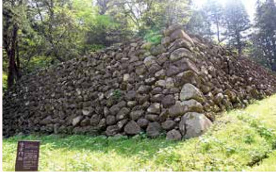
▲「野面積み」と呼ばれる、自然石で積み上げられた石垣「清水門跡」
