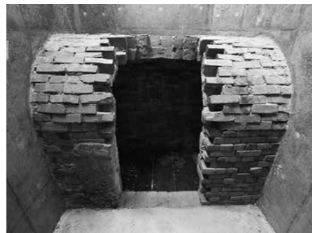
▲下水道管の側面に、見学の出入口を設けました
