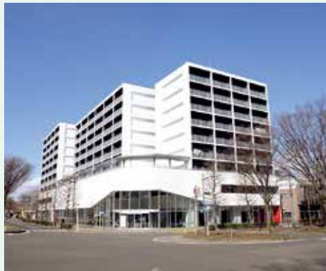
▲1・2階が卸町コミュニティプラザ。3階から9階は98世帯が入居する復興公営住宅
