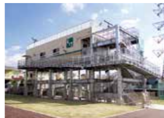
津波避難タワー
