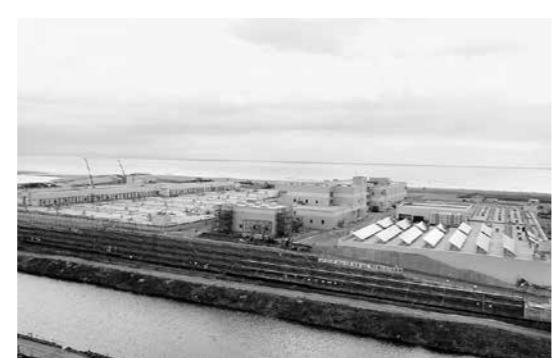
全体的にかさ上げすることで津波に強い施設に
