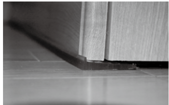
◀直接金具などで固定できない場合は、くさび形の転倒防止器具で家具の底面前部を持ち上げ、壁に押し付けて倒れにくくする方法もあります
