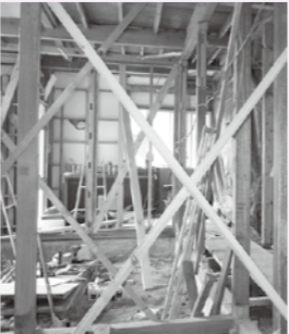
▲壁に筋交いを入れるなどの補強工事で、家の耐久性を高めました
