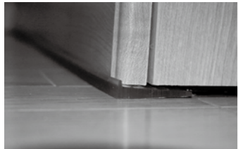
◀直接金具などで固定できない場合は、くさび形の転倒防止器具で家具の底面前部を持ち上げ、壁に押し付けて倒れにくくする方法もあります
