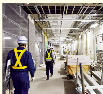
▲狭い空間で効率的に作業するため、資材はキャスターに乗せられています
