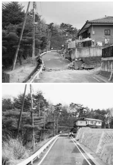
復旧前(上)と復旧後
