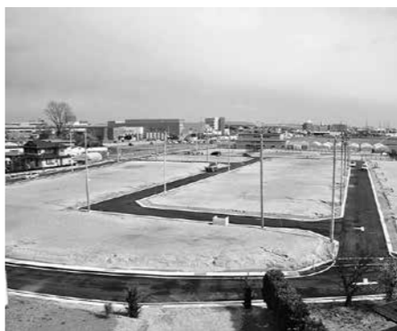
宅地の造成工事が完了した南福室地区
