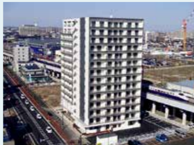
▲復興公営住宅3206戸のうち、約6割が完成。本年度末までに全ての完成を目指します(写真はあすと長町第二復興公営住宅)
