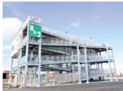
▲市ではタワー型やビル型などの津波避難施設を13カ所設置する予定です(写真は宮城野区中野五丁目の津波避難タワー)
