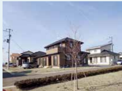
▲津波による被害を受けた東部地域では、防災集団移転促進事業を実施。13地区、733宅地全ての造成が完了しました(写真は若林区石場地区)
