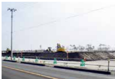
▲津波による被害を軽減するため、県道塩釜亘理線等を6メートル程度かさ上げる工事を進めています
