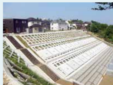
▲地滑りや擁壁崩壊などの被害が発生した丘陵地区等で完了した宅地復旧工事（写真は泉区南光台地区）
