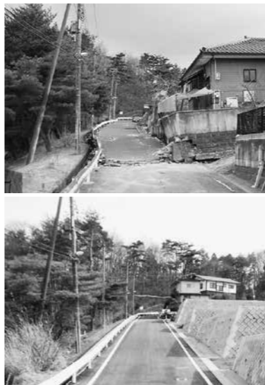
復旧前（上）と復旧後
