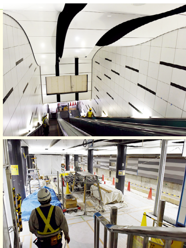
▲工事中の駅構内。ホームへ続くエスカレーターの天井(上)は、仙台七夕の吹き流しをイメージ
