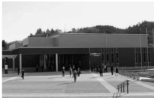
展示棟外観。北側は、地下鉄東西線・国際センター駅と近接
