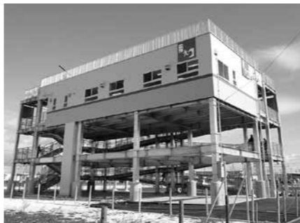
中野五丁目津波避難タワー。津波や漂流物の衝突も考慮した頑強な構造で、寒さから身を守る居室空間も設置
