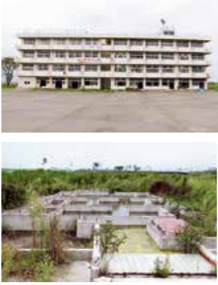
▶荒浜小学校（上）と住宅基礎群
