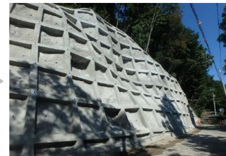
▲（施工後）定義仙台線 夜盗沢工区
