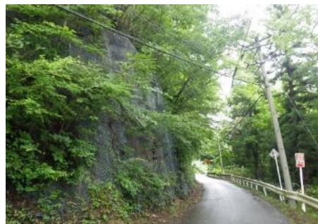
▲（施工前）定義仙台線 夜盗沢工区
