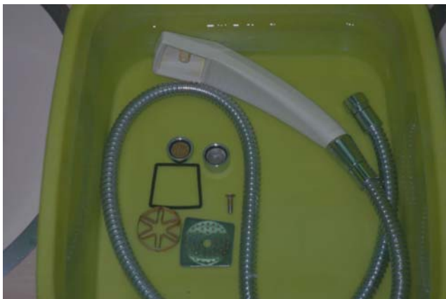
図2-2 シャワーヘッドの分解・清掃の例
