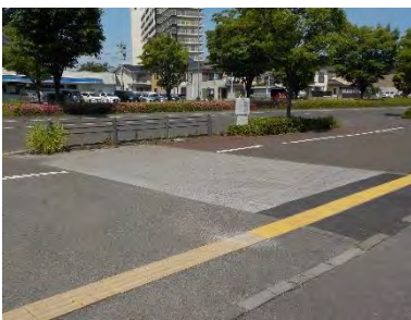
歩道舗装を利用 した遺構平面表示
