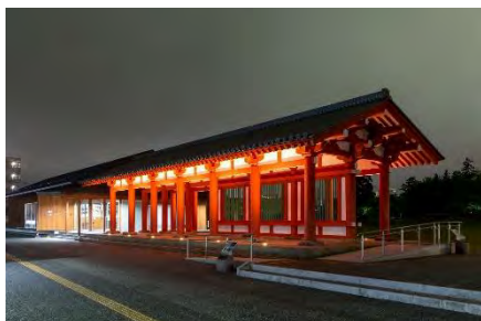
市内の整備事例写真
