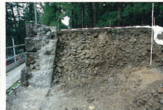
図6 中門北側石垣の裏込め
