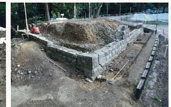
図7 中門北側石垣の解体状況
