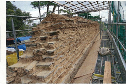
図3 土塀の外壁を外した状況
