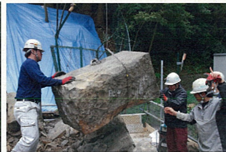
図 10 石垣解体作業 石工さんが 1 石ずつ解体していきます。
