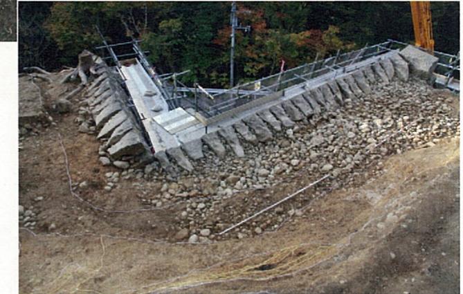
図 12 北部の石垣解体の状況 (上：解体前 下：解体途中)
