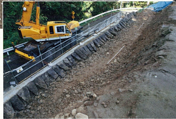
図 9 南部の石垣解体の状況 (上：解体前 下：解体途中)
