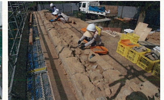
図4 解体部分の地覆石
