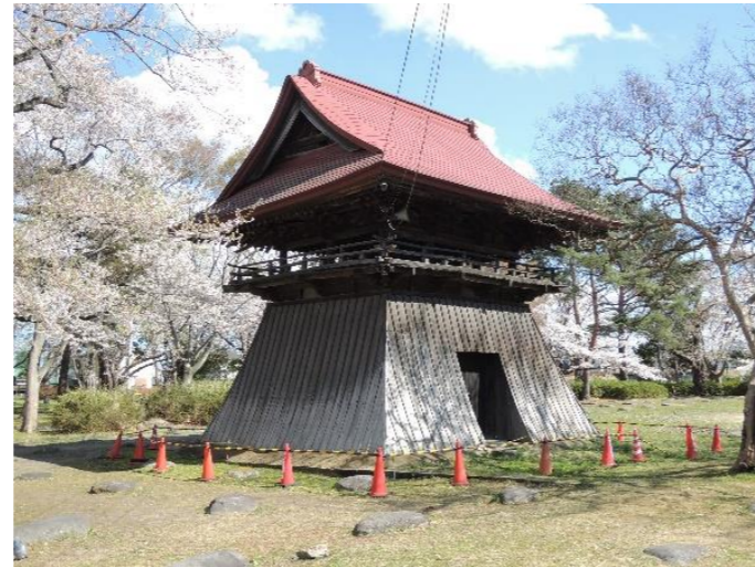
写真1 解体前の鐘楼（北西から）
