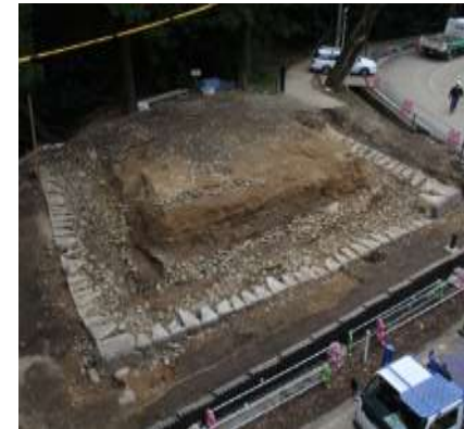
3 中門北石垣の被災状況
