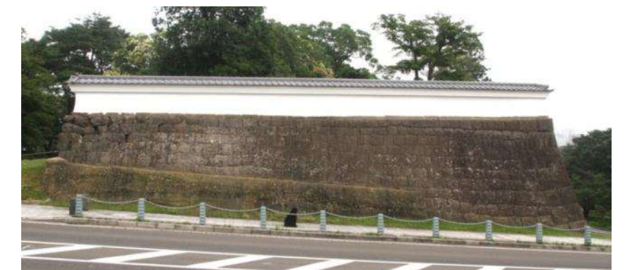
11 土塀の復旧状況
