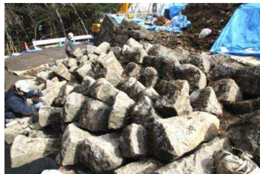
6 崩落石材の清掃と測量 (①～②)
