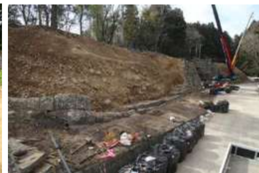
8 解体後の状況 (③)
