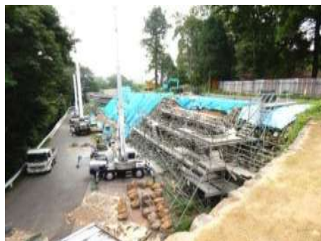
7 解体作業状況 (②～③)
