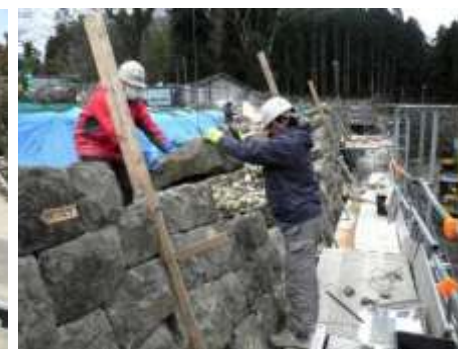
9 石の据え付け作業 (④～⑤)
