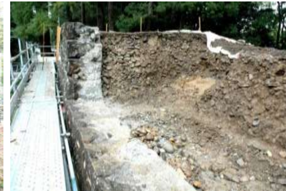
4 コンクリートで修復されていた中門北石垣
