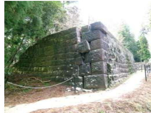
3 中門北石垣の被災状況
