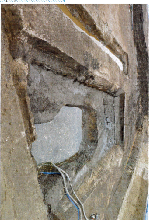
SD 5 高瀬堀 (東から)
