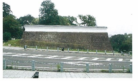
修復後の大手門北側土堀・石垣 仙台城跡で唯一残っている江戸時代からの建造物です。
