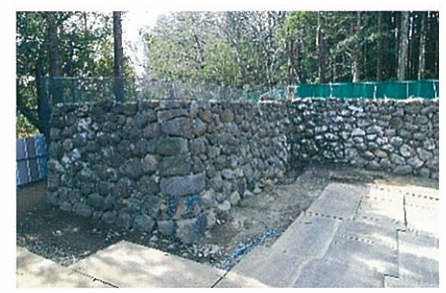
修復後の西門石垣 自然石をそのまま積んだ野面積みの石垣が多く残っています。
