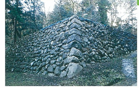
修復後の清水門石垣 古写真を元に、隅角部の石材を昔の積み方に戻しました。
