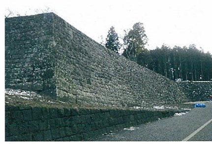
修復後の本丸北西石垣 江戸時代から今までに何度も修復していることがわかりました。
