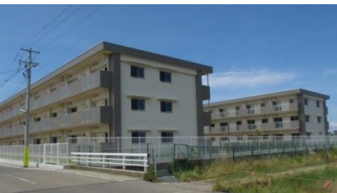
南東側からの外観
