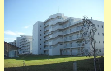
▲平成26年に入居が始まった若林西市営住宅
