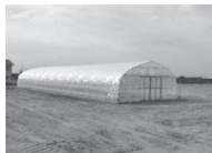
▲完成した ビニールハウス
