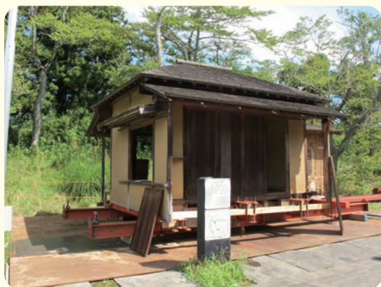
▲移築直前のため鉄骨に乗った状態の残月亭
