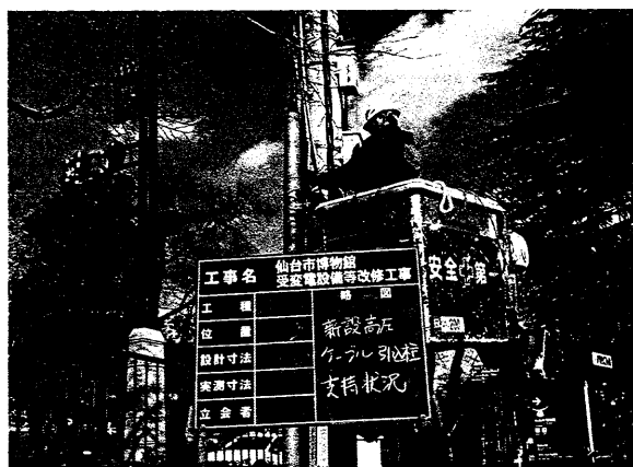
受変電設備ケーブル工事作業状況
