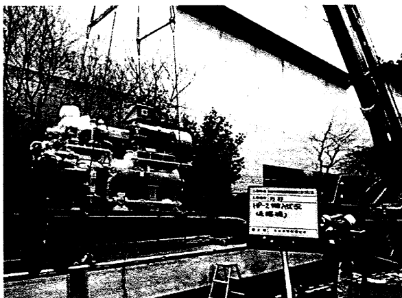
空調設備改修工事（搬入時）
