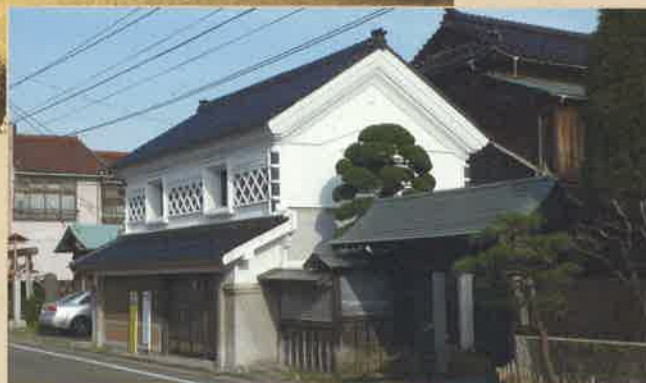
明治時代に建てられた土蔵造りの町屋(若林区南材木町の旧針惣旅館 平成22年撮影)
