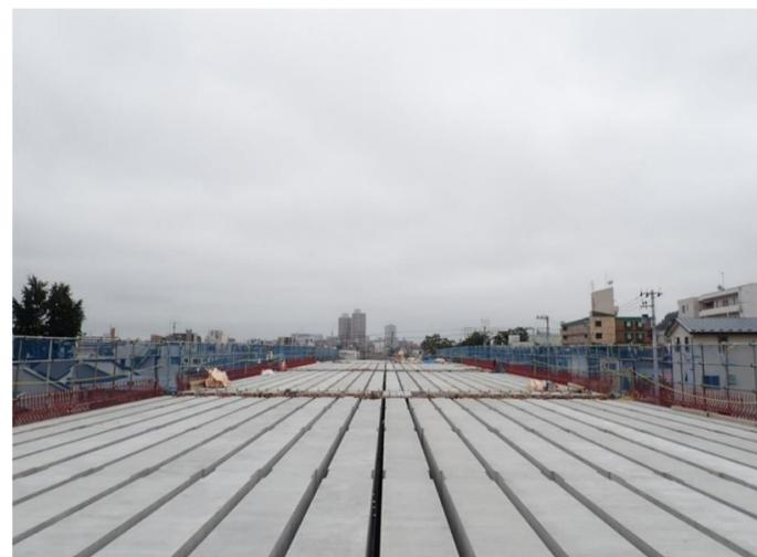
その4工事主桁架設完了(橋面上から撮影)
