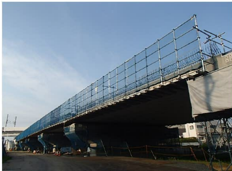
その4工事主桁架設完了(県道荒井荒町線沿いから撮影)
