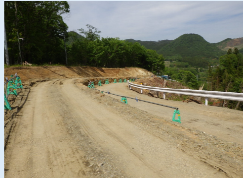
【仮設道路設置状況】
