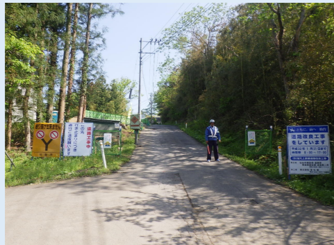
進捗写真 【場内出入口】
