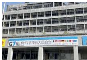
吊看板(市役所本庁舎)
