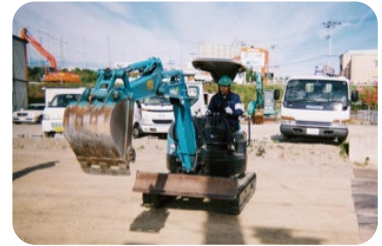
土木科(建設工事)
