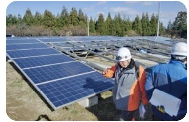
電気科(ソーラー発電施設工事)
