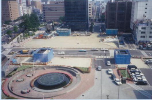
勾当台公園 昭和31年開園（平成元年リニューアル） 【整備中の市民広場】
