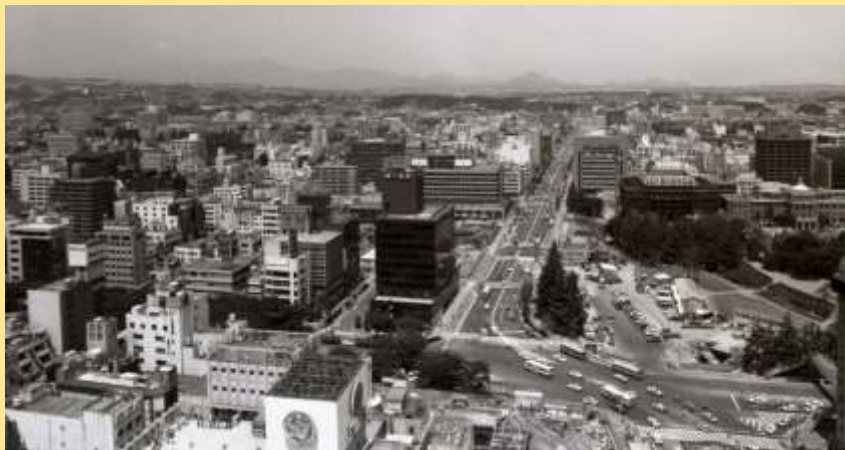
【東二番丁通と勾当台通との直線化（クランク解消）工事】
