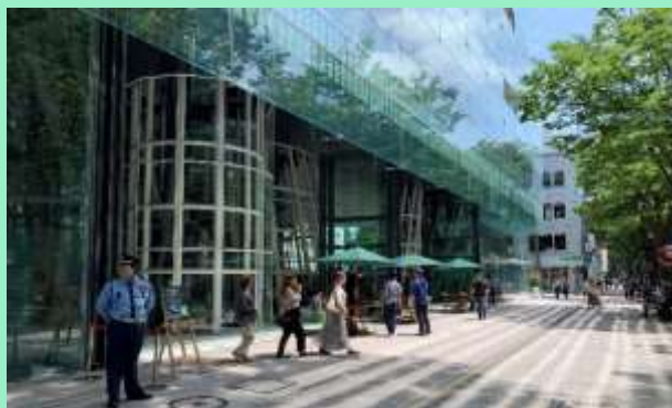
せんだいメディアテーク 平成12年完成
