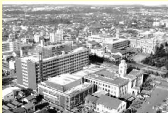
市役所本庁舎 昭和40年完成
