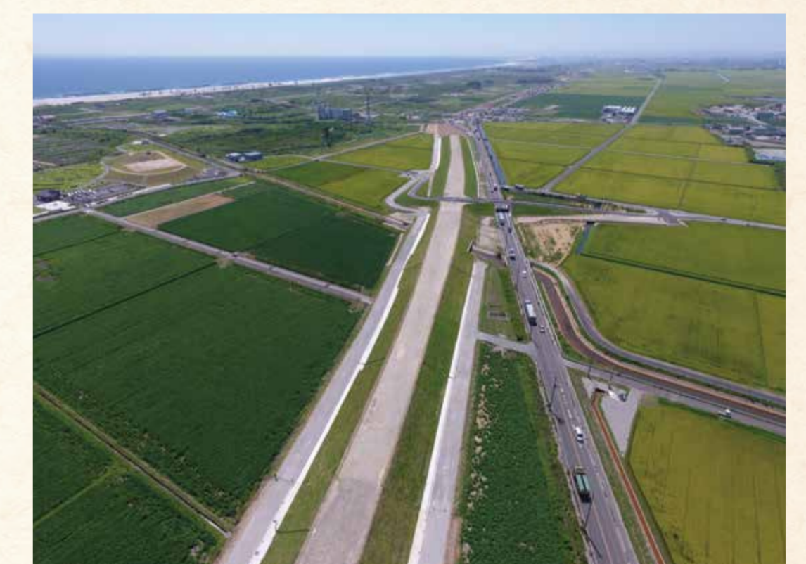
約6メートル盛土し、堤防機能を持たせた「東部復興道路(かさ上げ道路)」の工事が進行中 / 2018年8月
