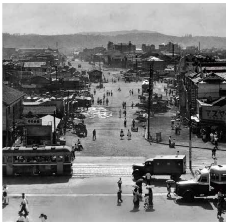
青葉通の工事 昭和25年 1950年
