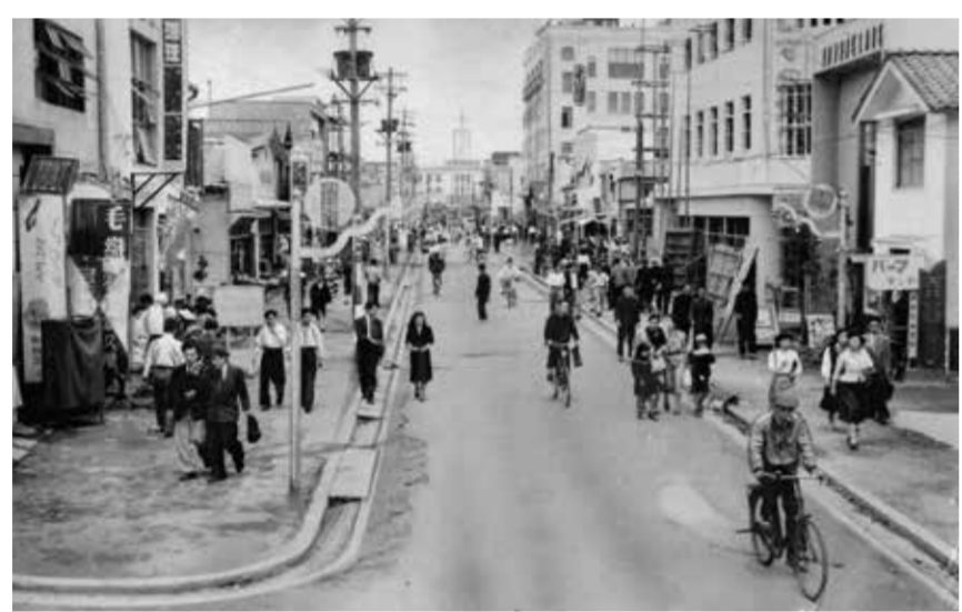
拡幅された東一番丁通 昭和26年 1951年
