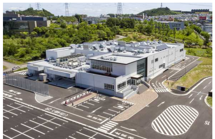
食物アレルギー対応食提供が可能な学校給食センターを整備
