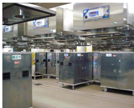
荒巻学校給食センター コンテナ消毒室 〈現在〉
