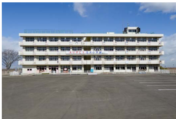
震災遺構 仙台市立荒浜小学校
