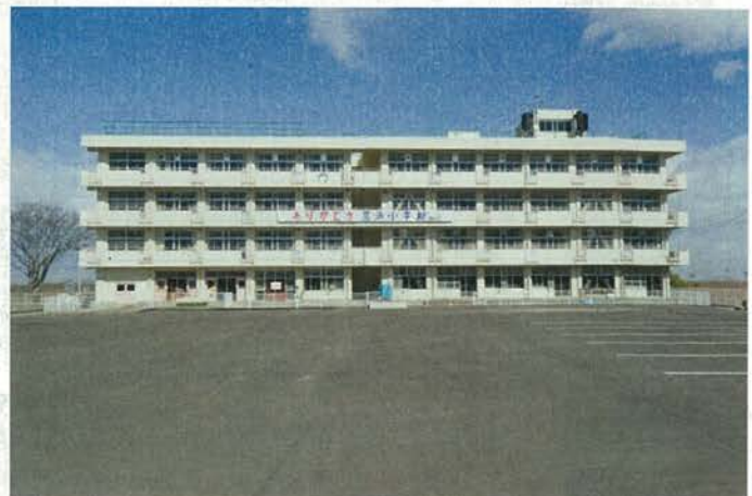
震災遺構 仙台市立荒浜小学校
