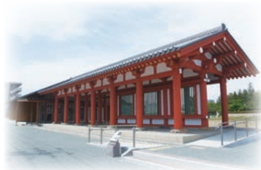
史跡陸奥国分寺・尼寺跡ガイダンス施設
