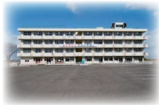
震災遺構 仙台市立荒浜小学校
