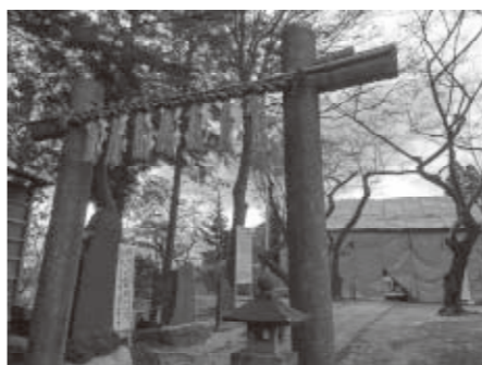
震災で上部が落ちた石鳥居。奥の楼門は復旧工事で依然シートで覆われていました
