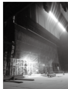
▶舞台奥から見たホール。客席部分には足場が組み立てられ、物々しい雰囲気の中で工事が進んでいます
