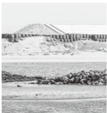
七北田川の河口部右岸、南蒲生浄化センター東側の海岸堤防は、今年3月に完成しています
