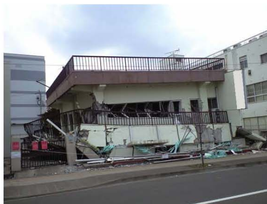
低層RC造の層崩壊が確認された
