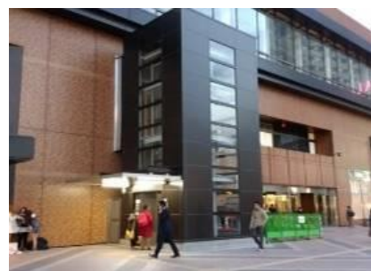
エレベーターの整備事例
