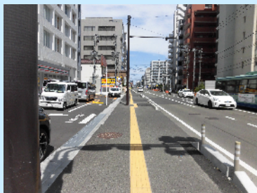
〈点字誘導ブロックの設置〉
