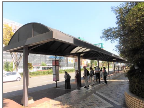
地下鉄長町南駅に隣接する バスターミナルの状況
