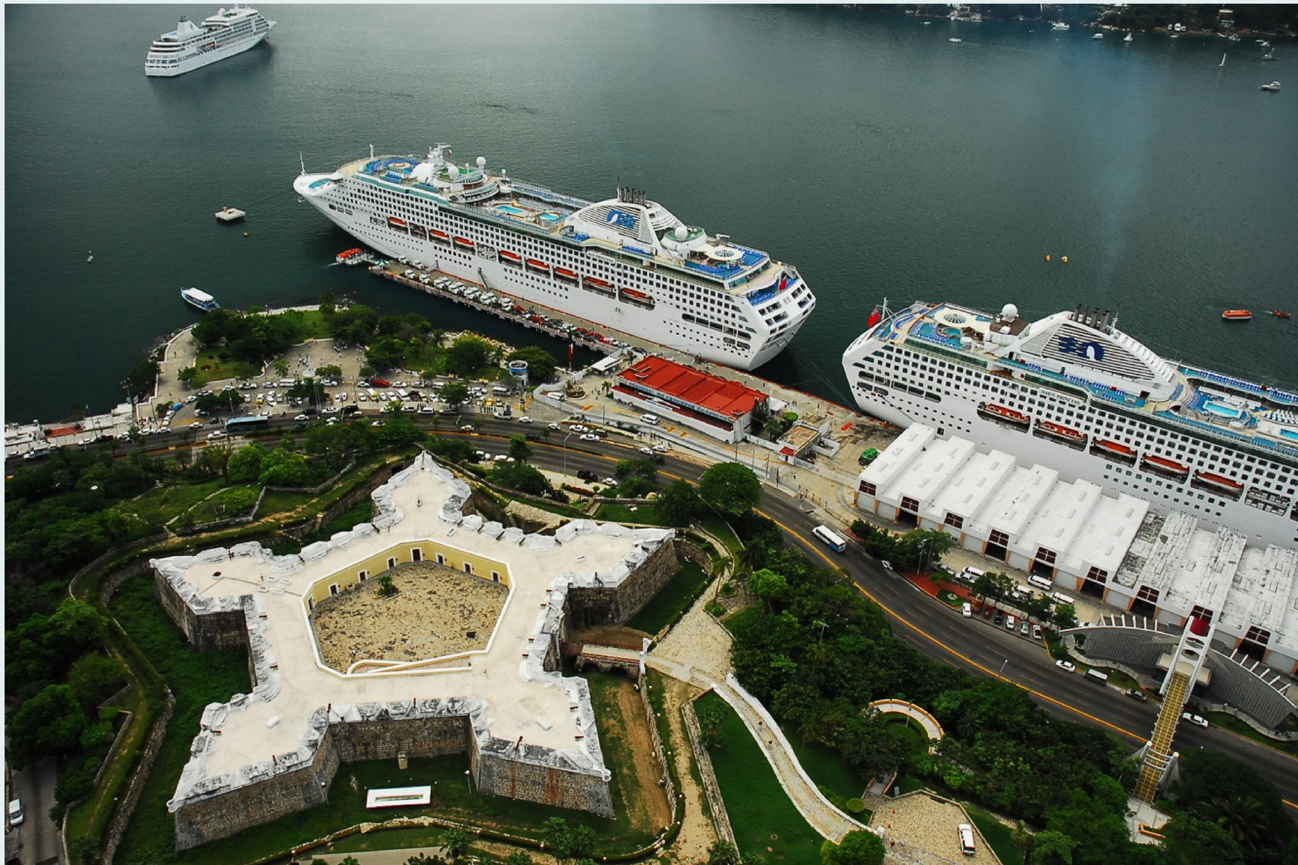
海賊の襲来に備えて建てられたサンディエゴ要塞（現在の建物は後に復元されたもの）
